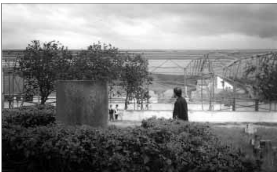
„Osatura metalică” de la Lancrăm, mai 2005
